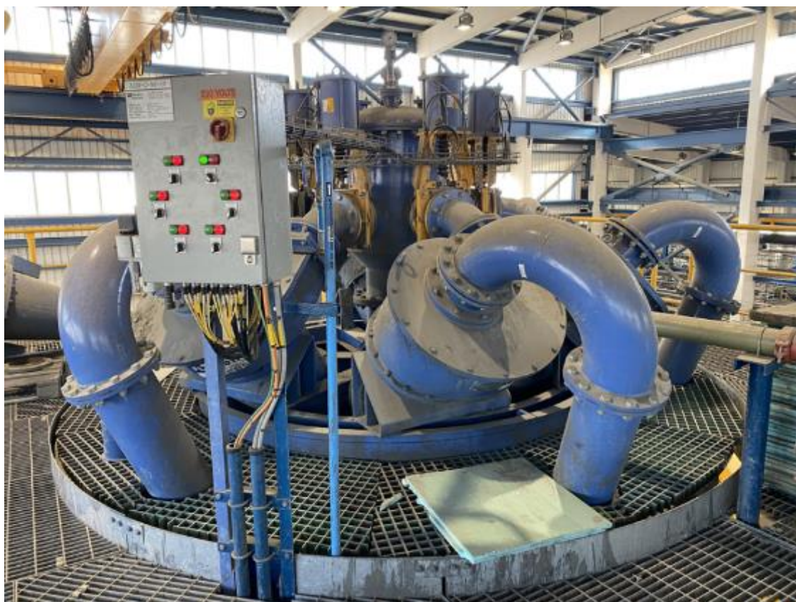
FIGURA 29: BATERIA DE CICLONES PRIMÁRIOS
