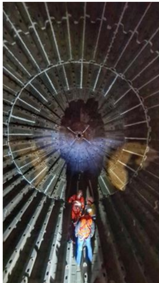
FIGURA 24: JOGO DE FORRAS COMPLETO INSTALADO NO INTERIOR DO MOINHO
